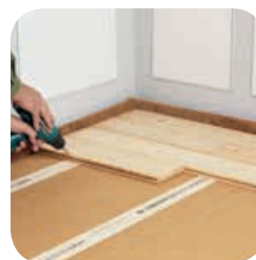
GUTEX Thermosafe-nf ® met profiellatten, geplaatst op een massieve plankenvloer
